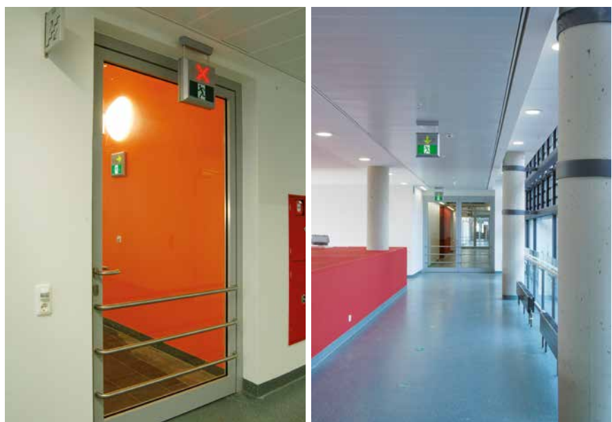
Bild 15: Eingang Treppenhaus (links) und Flursituation im Klinikum (rechts)
