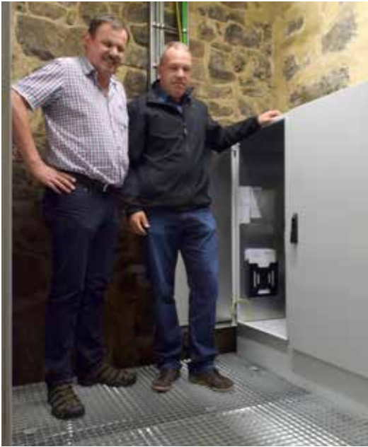
Horst Peter (Elektro Brückmann) und Axel Schwedes (INOTEC) vor der eigens für das Projekt konzipierten Sonderanlage
