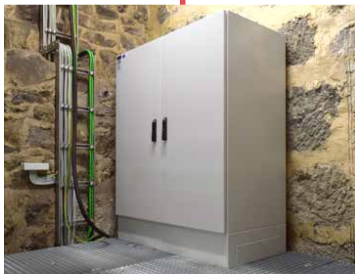
Einbausituation des Zentralbatteriegeräts im Gewölbe Installation location of the central battery system
