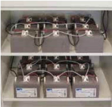
Während des wöchentlichen Funktionstests sollen auch die Batterien überwacht werden. Eingesetzte Batterieüberwachungssysteme müssen die Einzelblockspannungen ermitteln und auswerten können.
