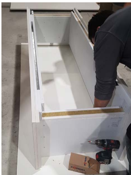
1. Montage des Brandschutzgehäuses in der Ausführung als Bausatz
