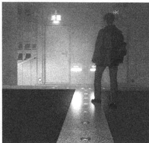
3 Die Simulation ist günstiger als der Ernstfall. Die Türleuchte ist nur schwach erkennbar, die Wandeinbauleuchten in Bodennähe bereits besser. Die Bodeneinbauleuchten zeigen gut erkennbar den Fluchtweg.
