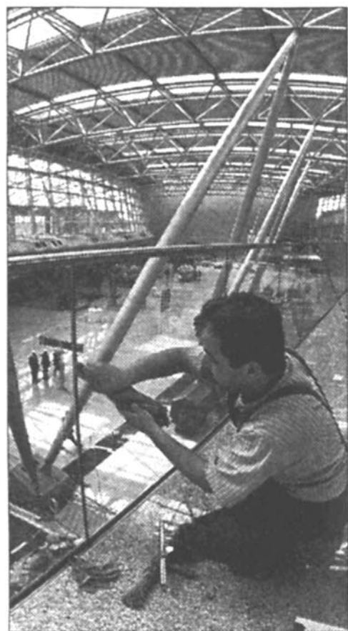
Großes Reinemachen vor der Eröffnung: Ein Arbeiter säubert eine Glasscheibe im neuen Terminal B des Düsseldorfer Flughafens. Bild: dpa
