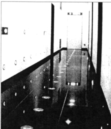
Der Vorführraum im Höinger Unternehmen Inotec ist komplett mit Notlicht-Systemen ausgerüstet.
