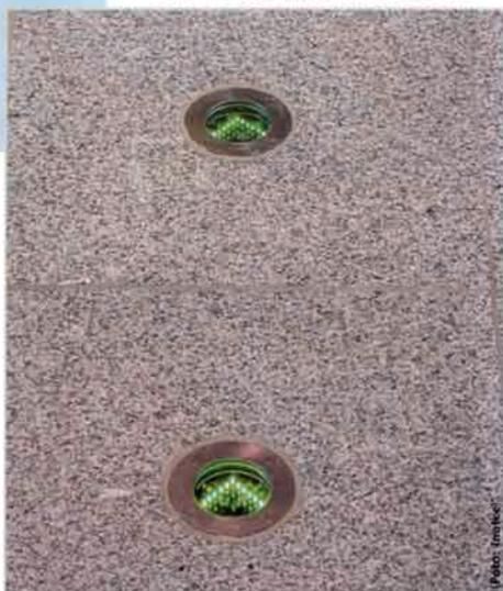
Die Bodeneinbauleuchten präsentieren sich mit Edelstahlgehäuse, bruchsaurem Hartglas für extreme Belastung, umschaltbarer LED-Steuerung und Einzeladressierung
