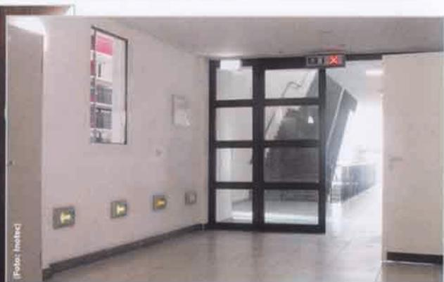
Nicht durch die Tür – sie ist gesperrt. Die bodennah montierten Wandleuchten weisen eindeutig in die sichere Richtung
