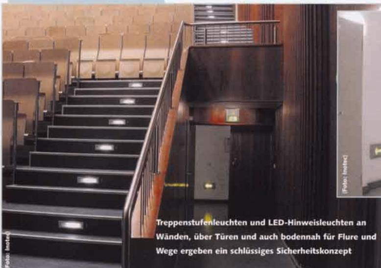
Treppenstufenleuchten und LED-Hinweisleuchten an Wänden, über Türen und auch bodennah für Flure und Wege ergeben ein schlüssiges Sicherheitskonzept
