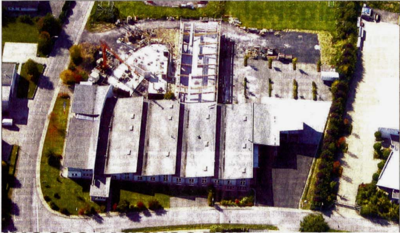
Die aktuelle Luftaufnahme macht das Ausmaß der Erweiterungsarbeiten an der Firma Inotec im Höinger Industriepark deutlich.
