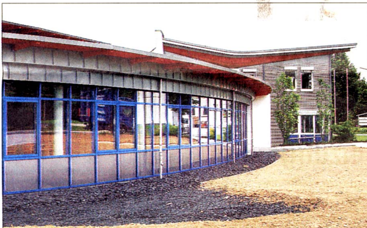
Der Erweiterungskomplex der Höinger Firma Inotec Sicherheitsleuchten: Allein durch die Vegetationsschicht erhöht sich das Gewicht des Daches um 45 Tonnen. ■ Foto: Mause
